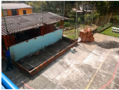
Vista exterior nueva cocina
